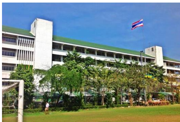
อาคารนนทสิริวัฒน์
